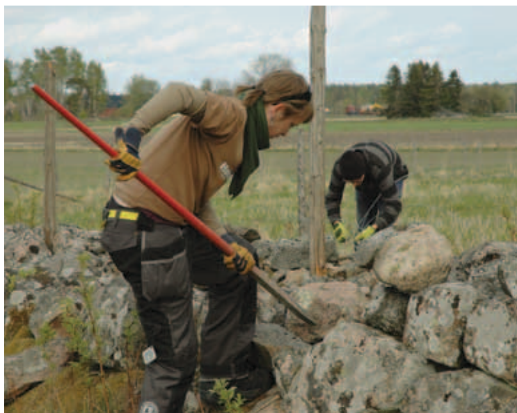
Figur 3. Gärdsgårdsbygge och reparation av fägata på Vallby Sörgården. Foto: Sigun Gröning 2011.
