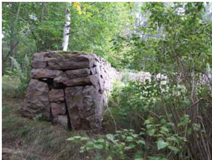
Figur 1. Murens avslut ställer höga krav. Den behöver ha rätta vinklar. Ett tränat öga kan se hur dessa stenar har bearbetats med slägga eller mejsel för att få sin rätta form. Foto: Joakim Lilja 2011.
