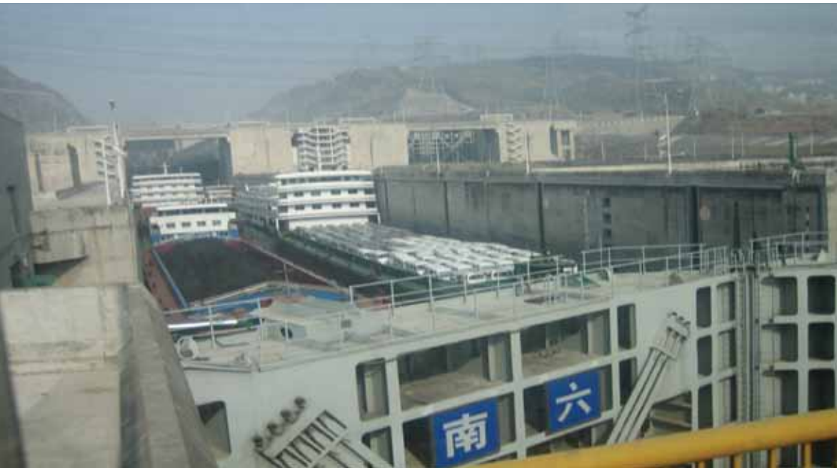
Figur 3. Nedslussning av två flodfartyg i den västra dubbelslussen vid Yichang. Det ena är lastat med kol, det andra med nya bilar.
